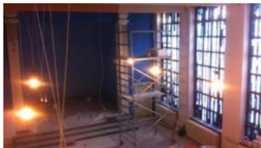
ROHBAU IST FERTIG
