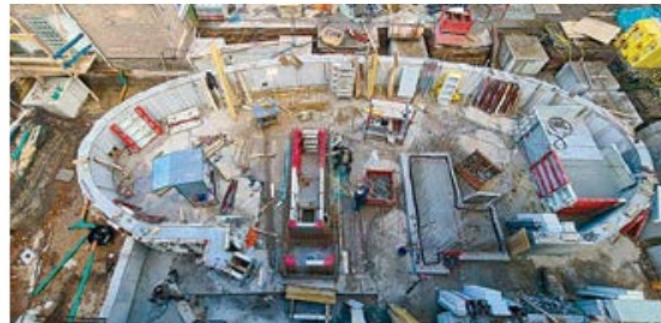
DER BAU UNSERER MIKWE HAT BEGONNEN
